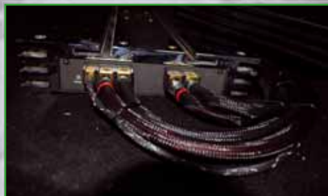
Auf die solide Verkabelung kann man sich verlassen
